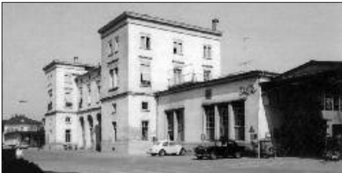
Für den Bahnhof Romanshorn plante Architekt Breitingen schon 1853 die einzigen grossen Hochbauten an der Bodenseebahn. Das Gebäude steht heute unter Denkmalschutz. (Foto: Reck 1979, Sammlung H.-P. Bärtschi)
