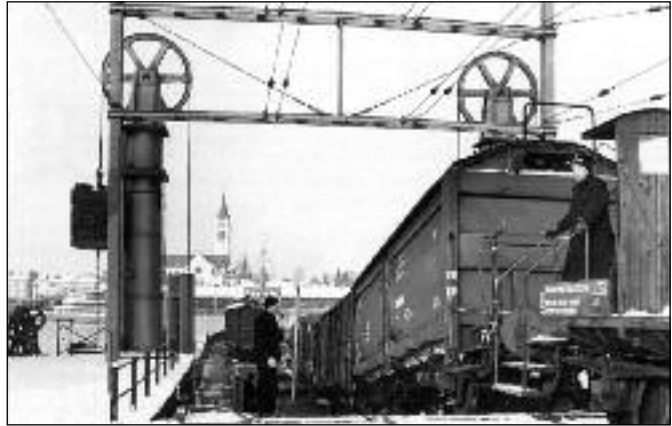
Über 100 Jahre lang, bis 1976, wurden Züge über den Bodensee verfrachtet. Die Trajekttrampe, welche die unterschiedlichen Seespiegel ausgleicht, dient heute dem Autoverkehr. (Foto: Sammlung kleines Museum am Hafen, Romanshorn)
